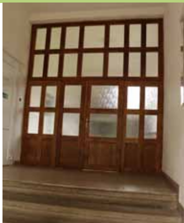
Nové dveře v budově obecního úřadu.
